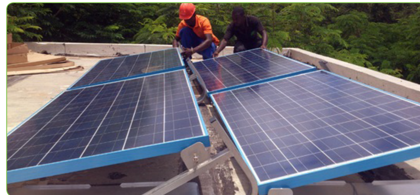
Installation de panneaux solaires
